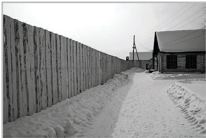
Забор в зоне строгого режима ИТК № 36. Реконструкция
