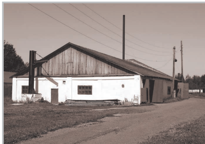
Производственные мастерские ИТК № 6. Современный вид
