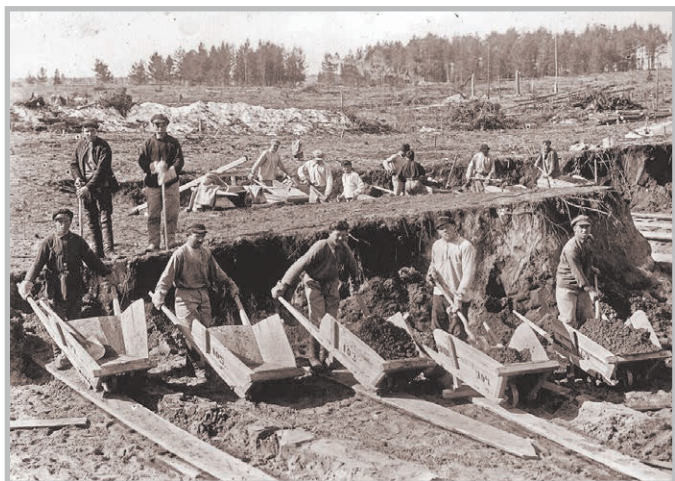
Заклученные на строительстве соцгорода. Краснокамск
