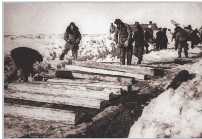
Строительство железной дороги
