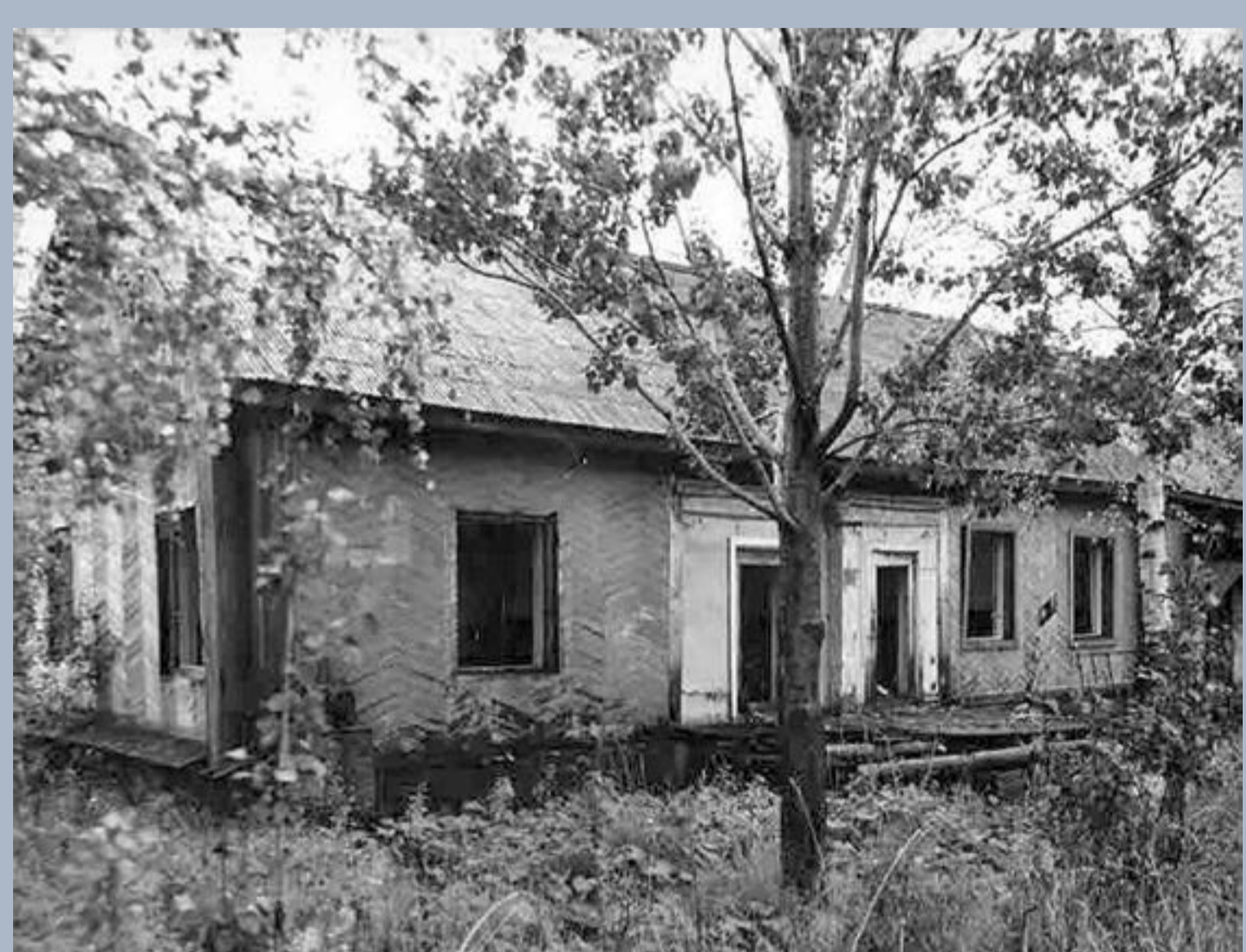
Здание медсанчасти на территории жилой зоны отделения строгого режима ИТК-36 (1990-е гг.)
