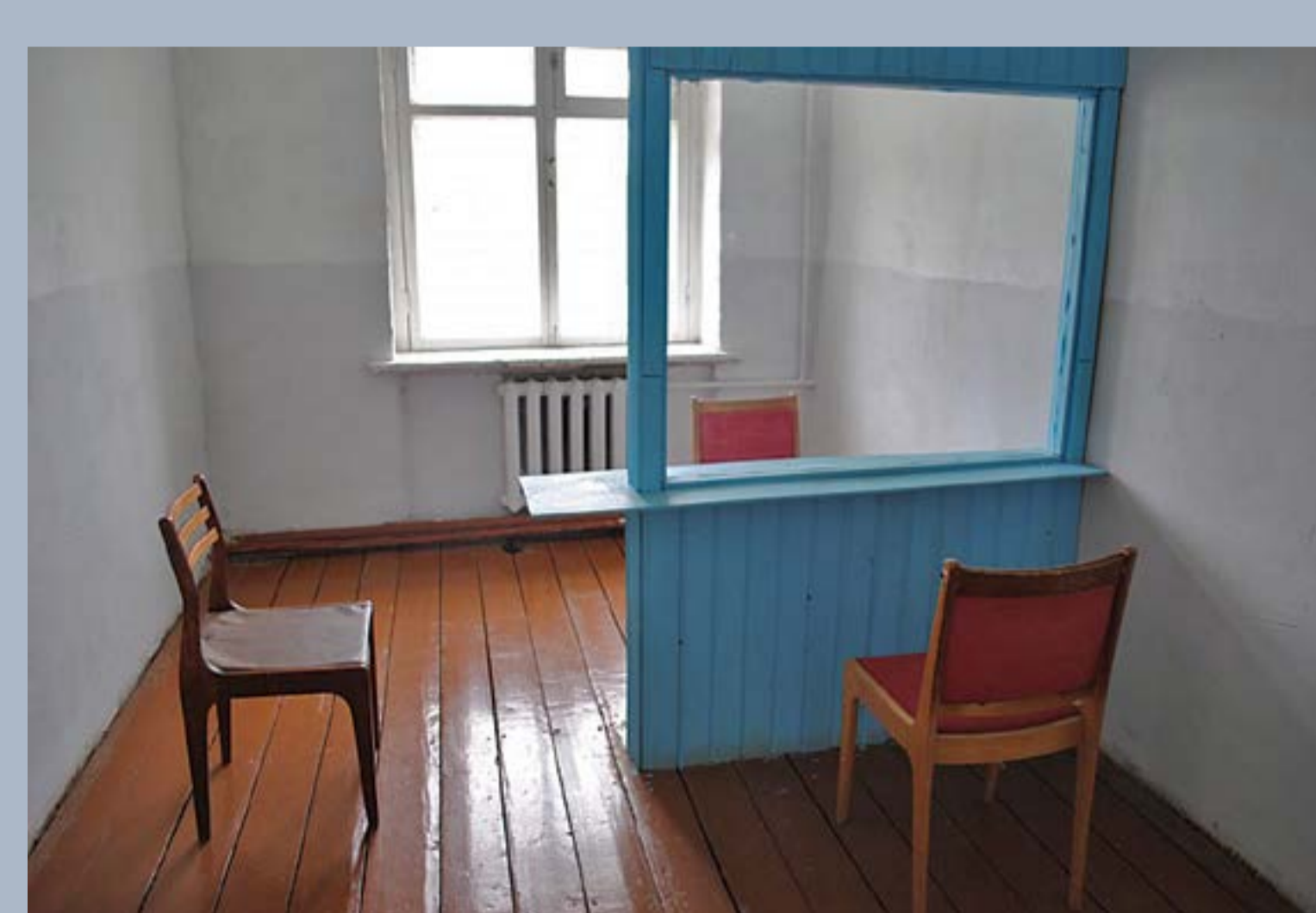
Комната для краткосрочных свиданий в здании штаба ИТК-36. Реконструкция.
